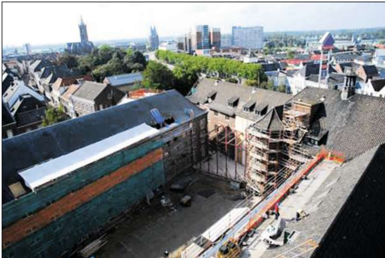
De sloop- en herbouwwerkzaamheden begonnen eind december 2010 en zijn voortvarend verlopen.
