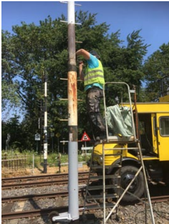
Het blank maken van de roestige plekken op de seinpaal (links) en dezelfde paal in afgebouwde toestand (rechts)
