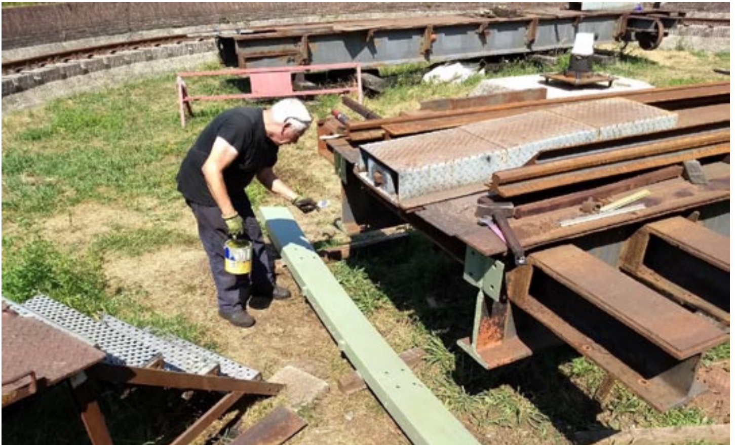
Vrijwilliger Hub Gort conserveert de brugdelen van de draaischijf
