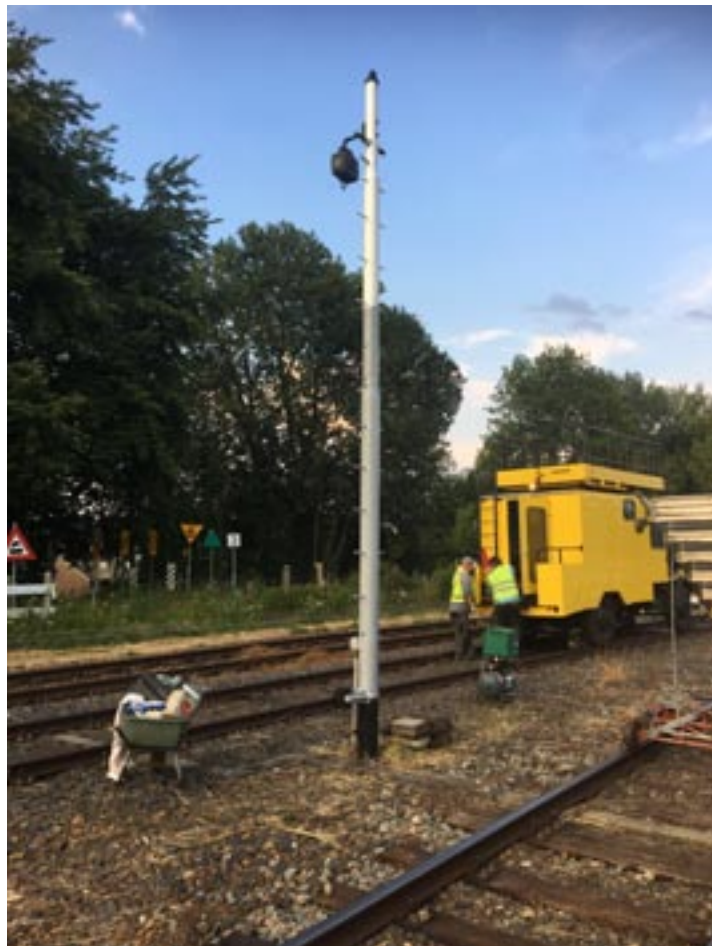
Het blank maken van de roestige plekken op de seinpaal (links) en dezelfde paal in afgebouwde toestand (rechts)
