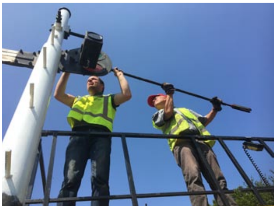
Het verwijderen van de trekstang en seinvleugel
