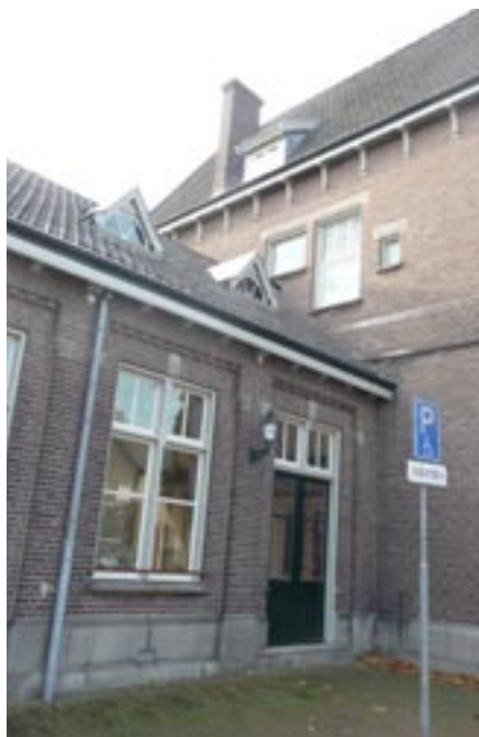
Alles weer in perfecte staat: geïsoleerd dak, houtwerk strak in de lak.
