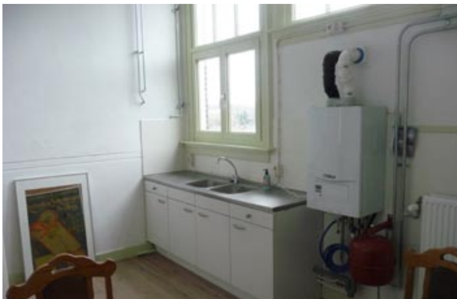
De keuken van de woning met nieuwe CV ketel.
