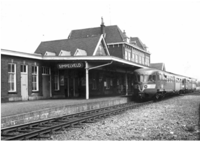
Station Simpelveld nog in volle omvang. De linkervleugel is later afgebroken tot aan het hoofdgebouw wat nu nog steeds aanwezig is. Oktober 1970.
