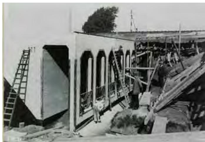
Aanleg viaduct Nijswillerweg Simpelveld, 1 oktober 1931.
