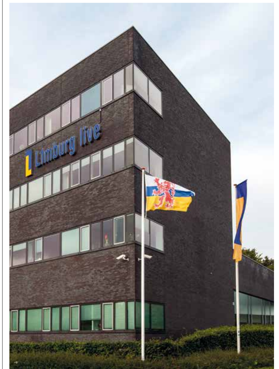
L1-gebouw in Maastricht
